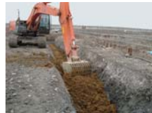
透過壁施工例
