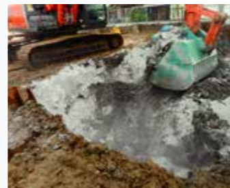
工場跡地「油類」施工例
