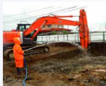
工場跡地「VOCs」施工例
