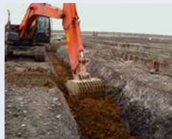
工場跡地「透過壁」施工例
