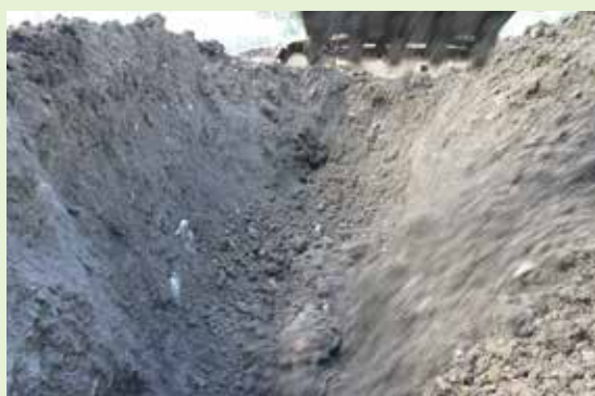
攪拌最終段階 粘性土が砂粒化 大型0.7 m 3 バックホー(スケルトン)
