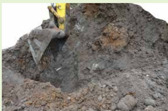
攪拌初期 粉体VOC分解剤使用例
